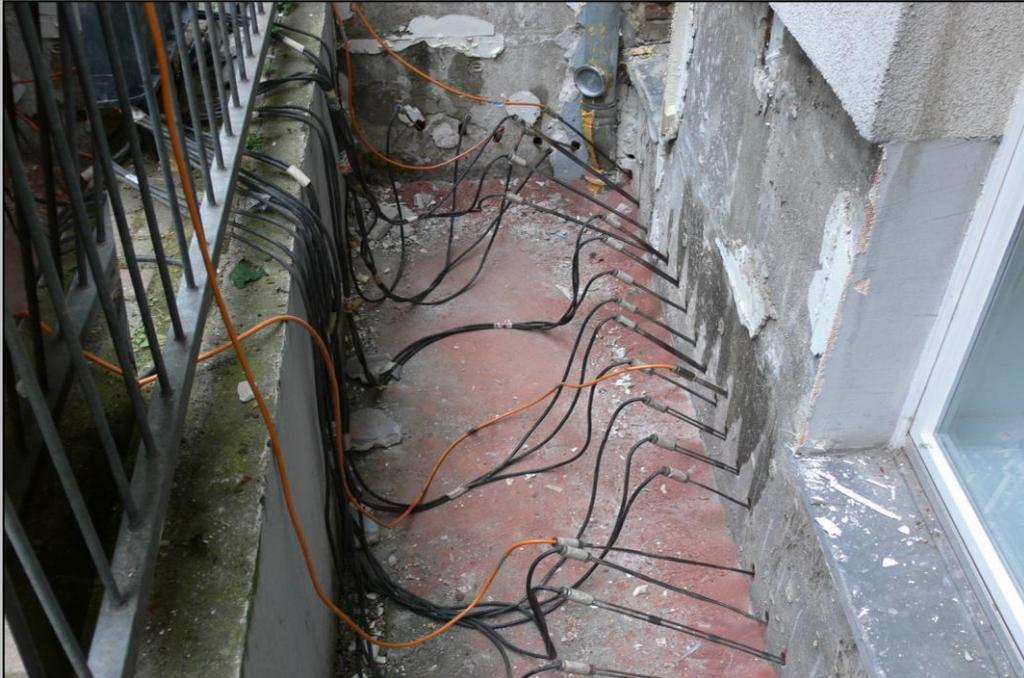
Foto 6 – Austrocknen des Mauerwerks mit Lanzen
