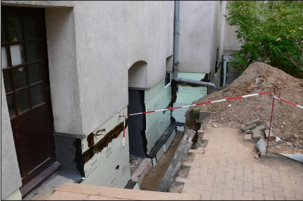
Foto 10 – vertikale Abdichtung (schwarz) Einbau bis über die Fundamentkante und Schutz der Abdichtung durch Dämmplatten (türkis) 17.09.2012
