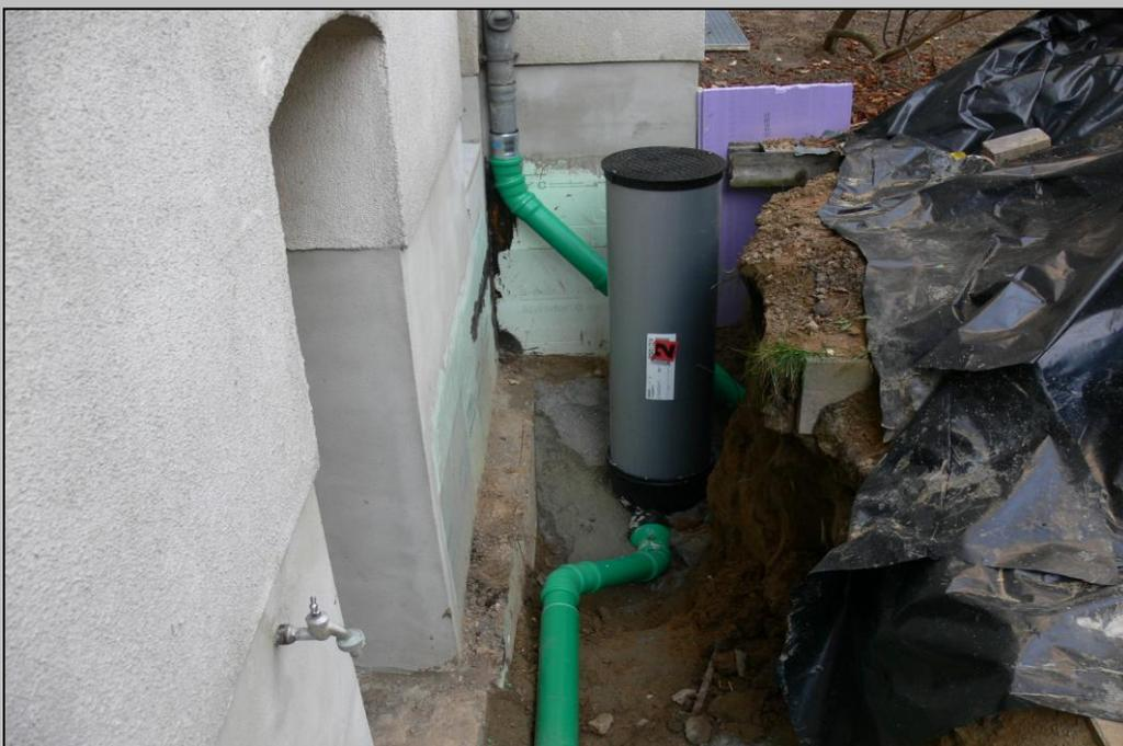
Foto 11 – neue Regenwasserleitungen mit Kontrollschacht
