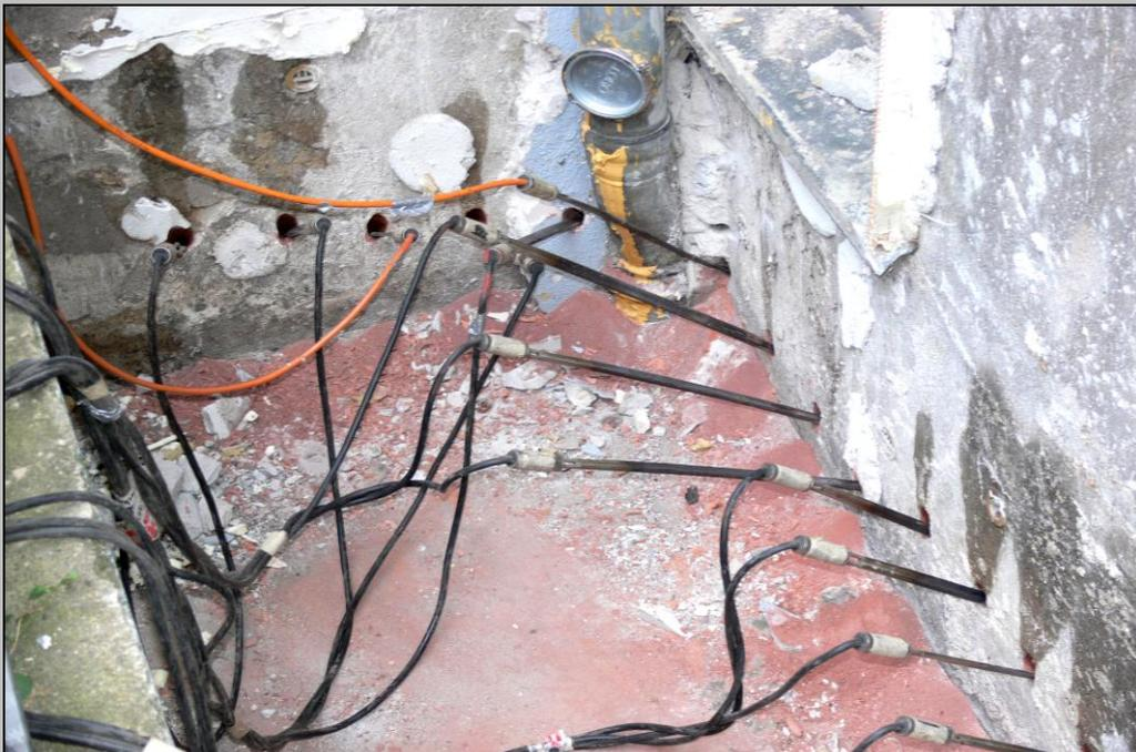
Foto 7 – Austrocknen und Bohrlochinjektion
