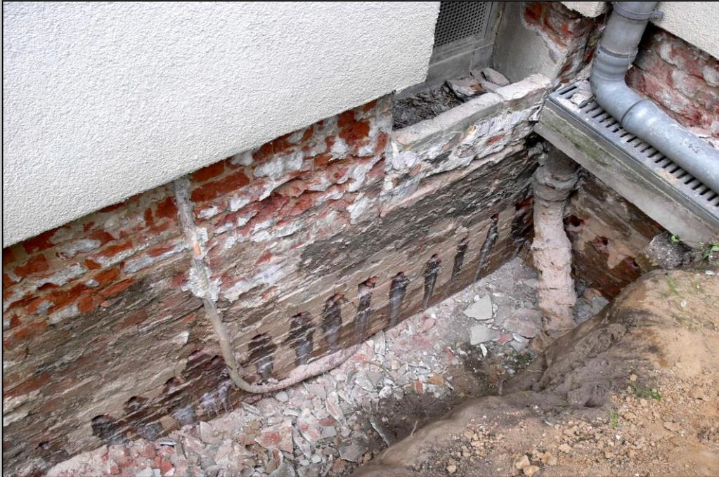
Foto 8 – Bohrlöcher nach dem Einbringen des Parafins (Mittel zur Herstellung einer horizontalen Abdichtung) 05.09.2012
