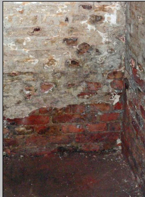
Fotos 2 und 3 – Feuchteschäden an den Kellerwänden, innen
