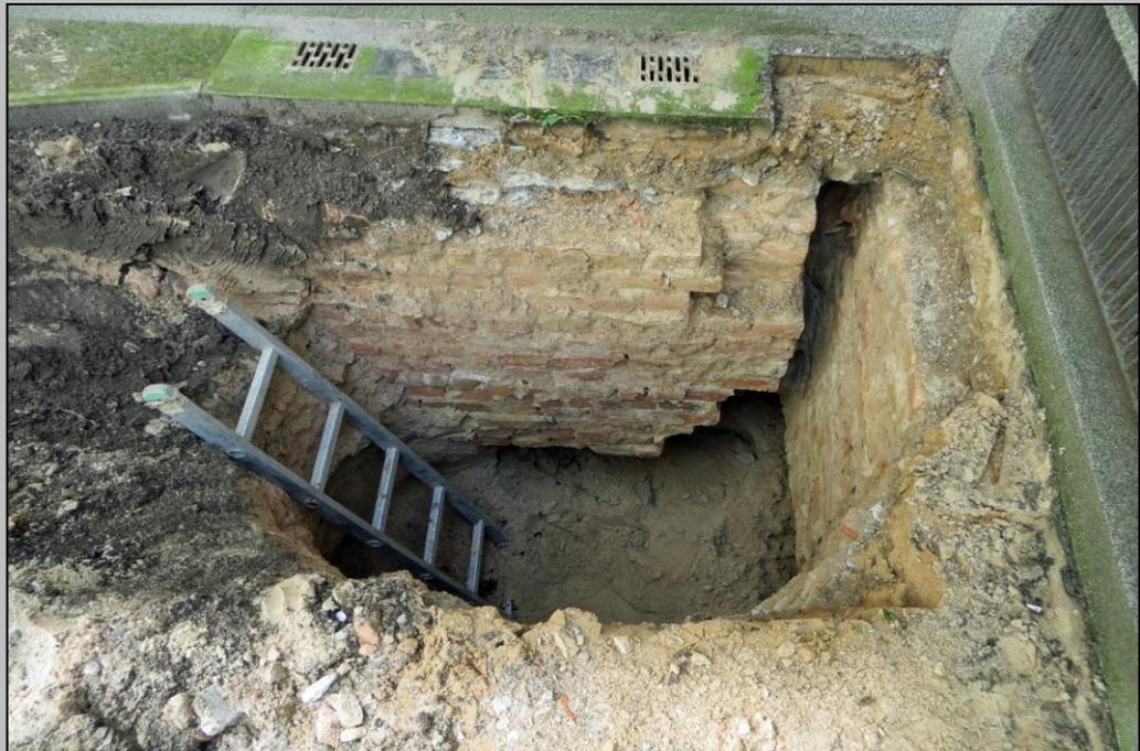
Foto 1 - Rückseite Vorderhaus, gemauerter Lichtschacht
