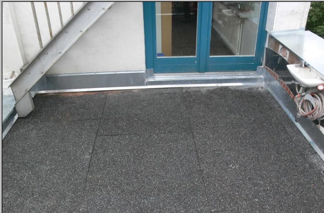
Foto 14 - Verlegen der Bautenschutzmatte
