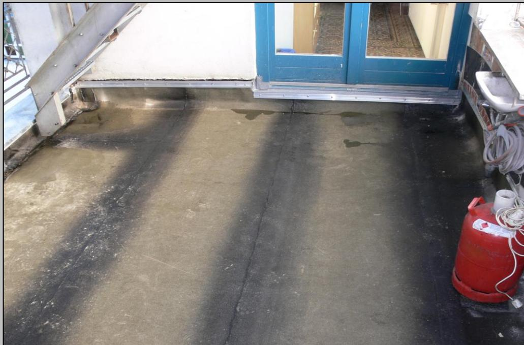
Foto 10 - Einbau der neuen Abdichtung
