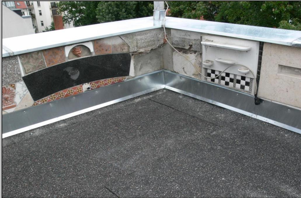
Foto 13 - Einbau der Zinkblechaufkantungen, Bautenschutzmatte 17.08.2010
