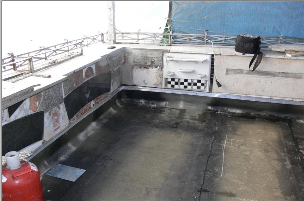
Foto 9 - Abdichten der Terrasse nach der Reparatur der Decke 04.08.2010
