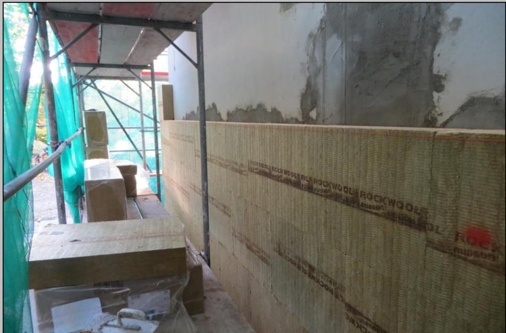
Foto 2.3 - Beginn der Wärmedämm-Maßnahme
