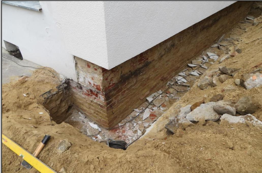
Foto 3.1 - Ausschichtungsarbeiten am Sockel
