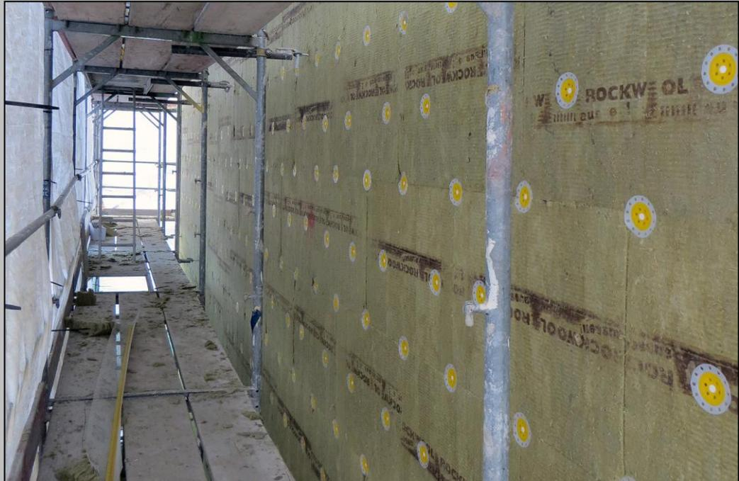
Foto 2.4 - Verdübelung der Dämmplatten, D=16 cm
