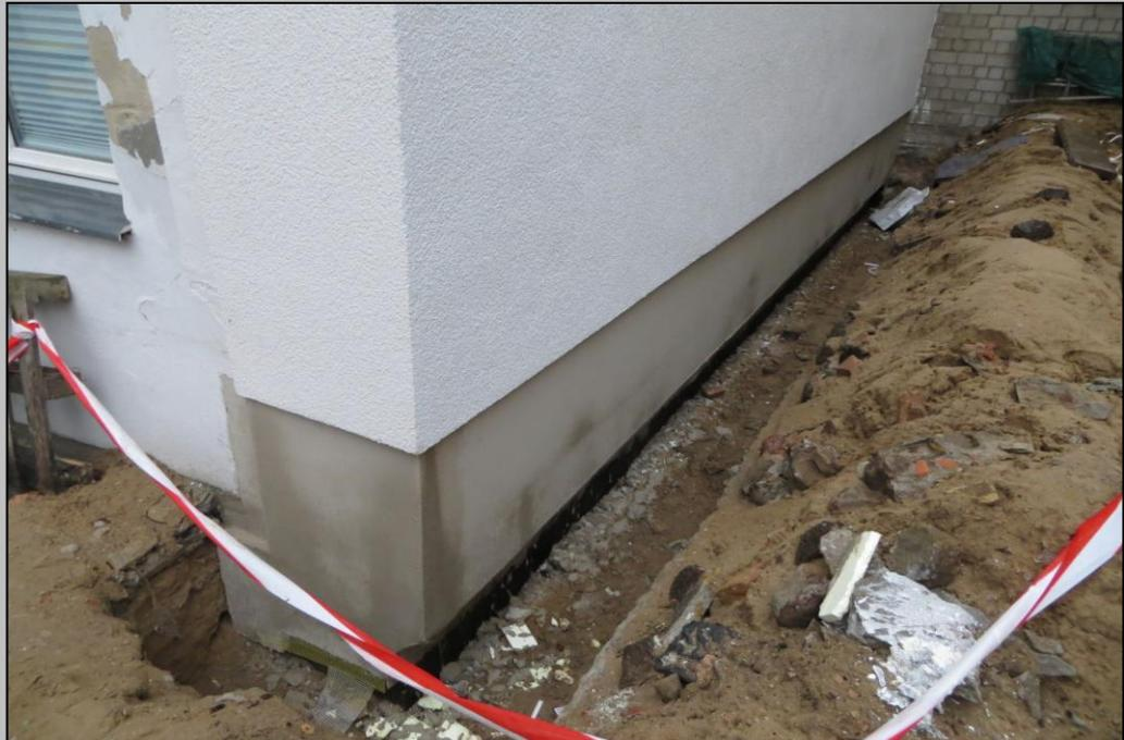
Foto 3.3 - Perimeterdämmung
