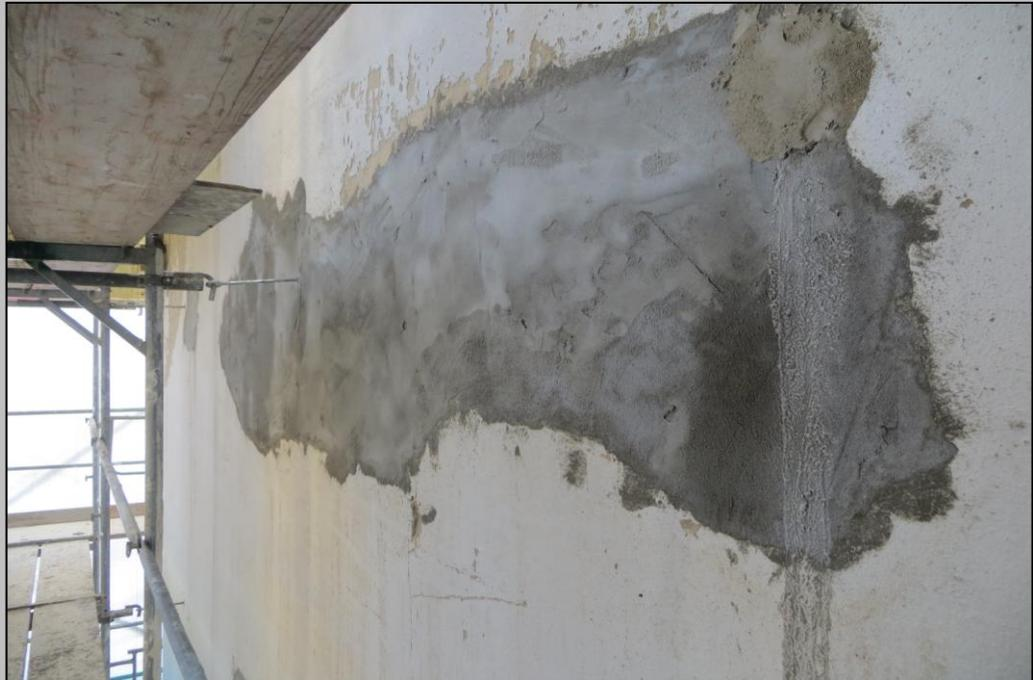
Foto 2.2 - Ausbesserung von Putzschäden
