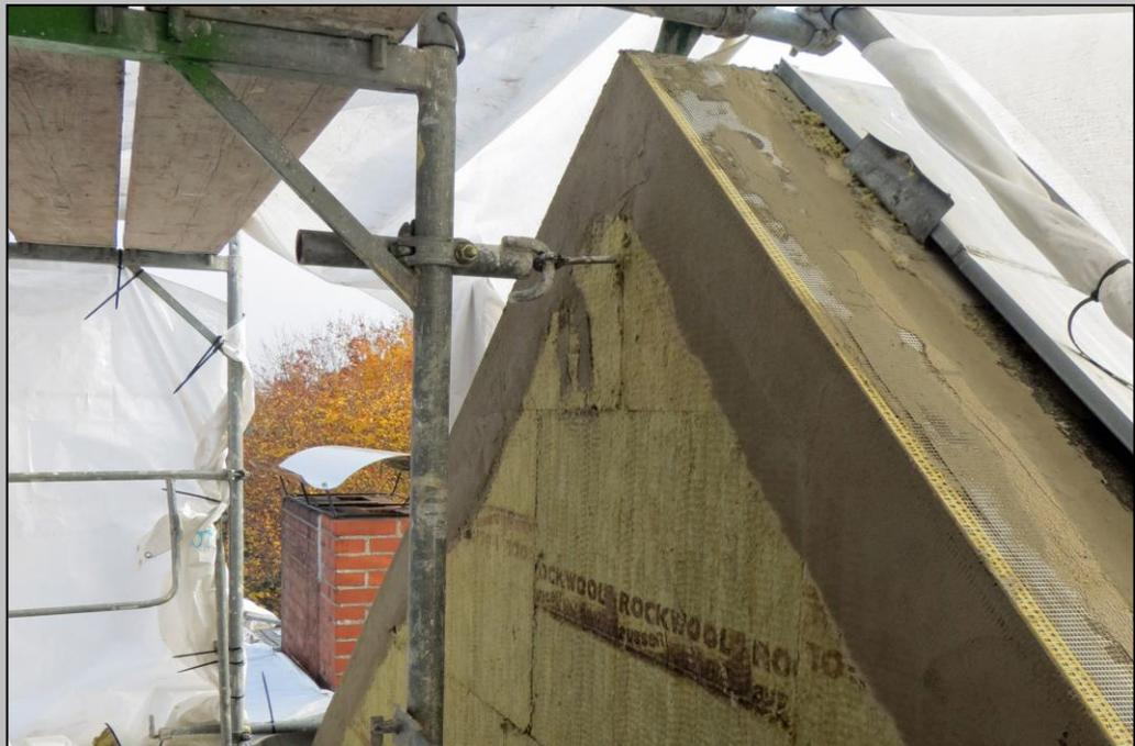
Foto 2.7 - Ausbildung des Giebels, Kantenschutzschienen
