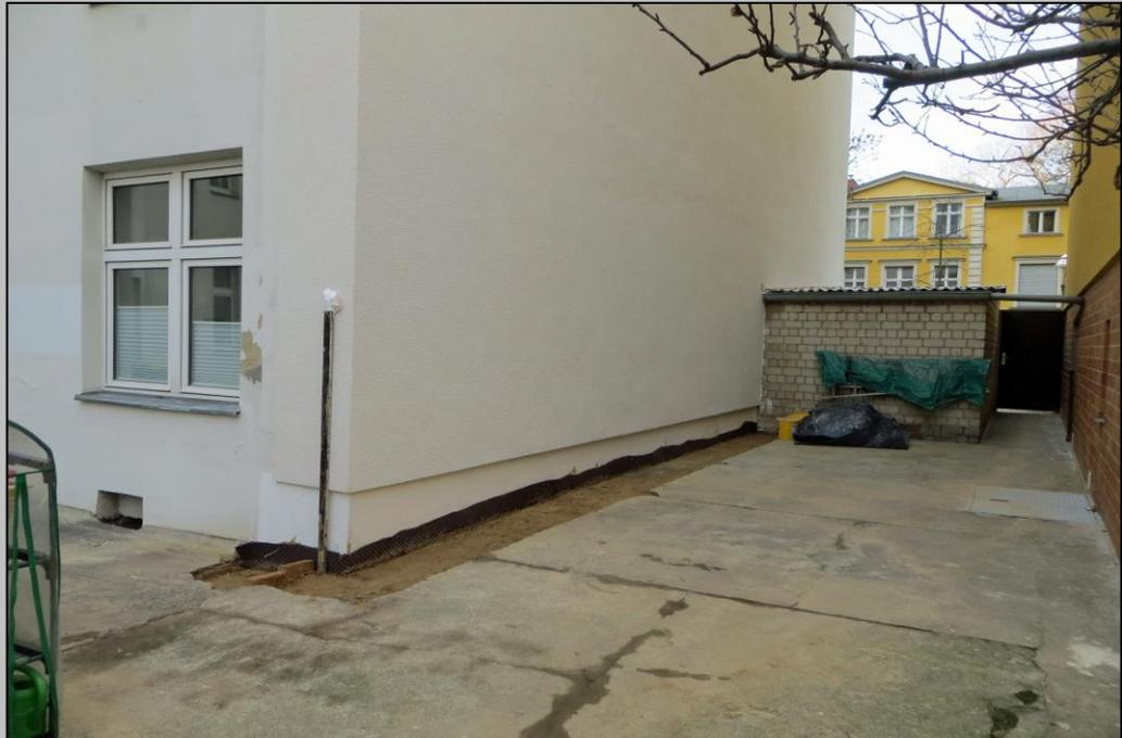
Foto 3.5 - verfüllte Baugrube
