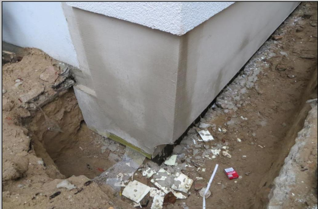
Foto 3.4 - Perimeterdämmung, Wandecke
