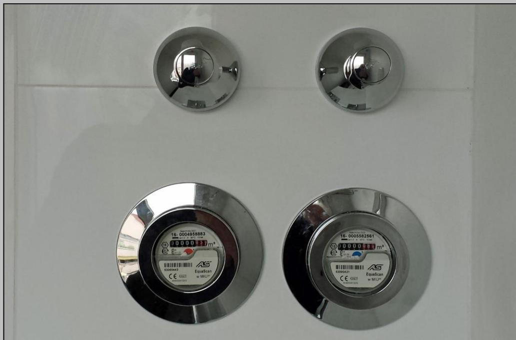
Fotos 2.3 - neue Warm- und Kaltwasserzähler und Absperrventile im Bad
