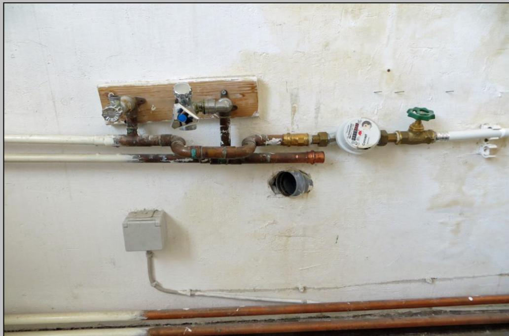
Fotos 2.3 - alter Kaltwasserzähler mit Absperrventil in der Küche
