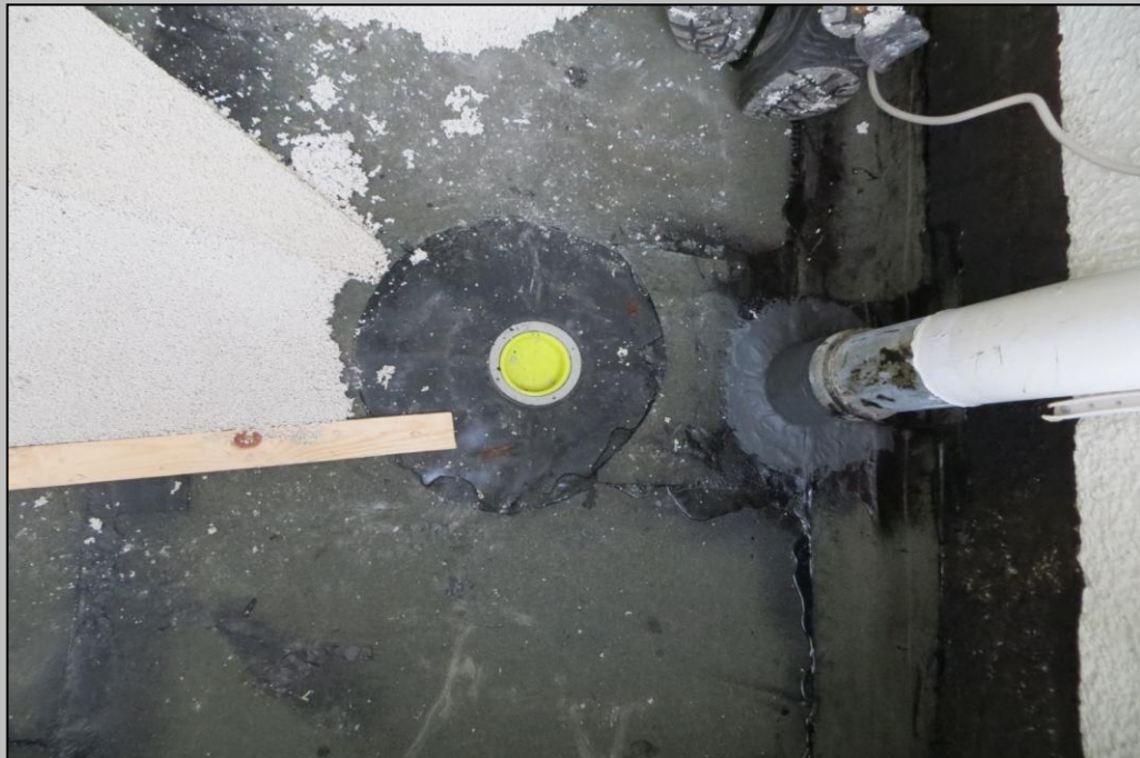
Foto 8 - Einbau der Gefälledämmung
