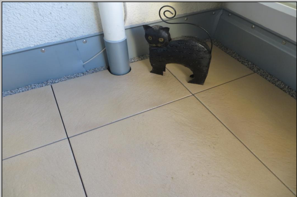
Foto 16 - Anschluss der Platten am Balkonrohr
