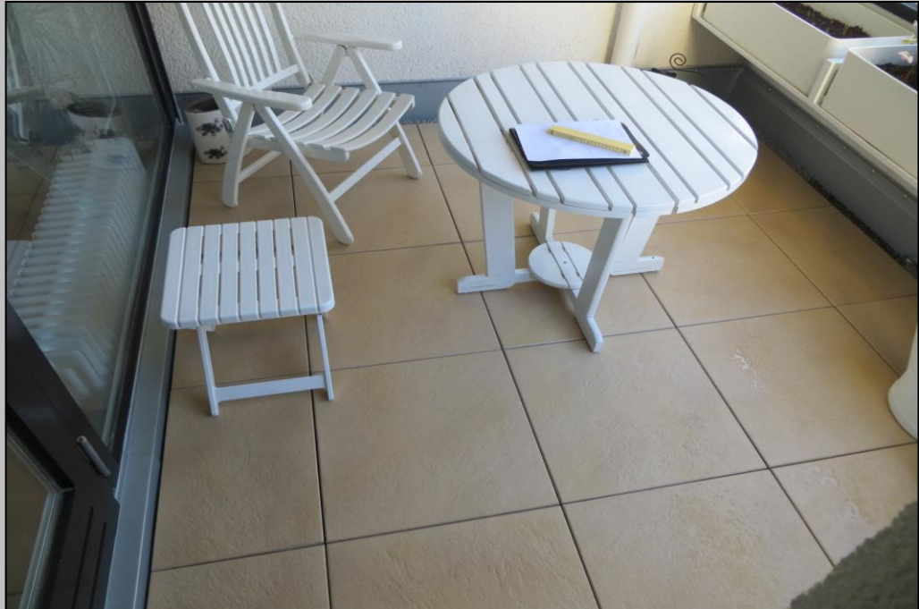
Foto 15 - Balkon nach Abschluss der Sanierung
