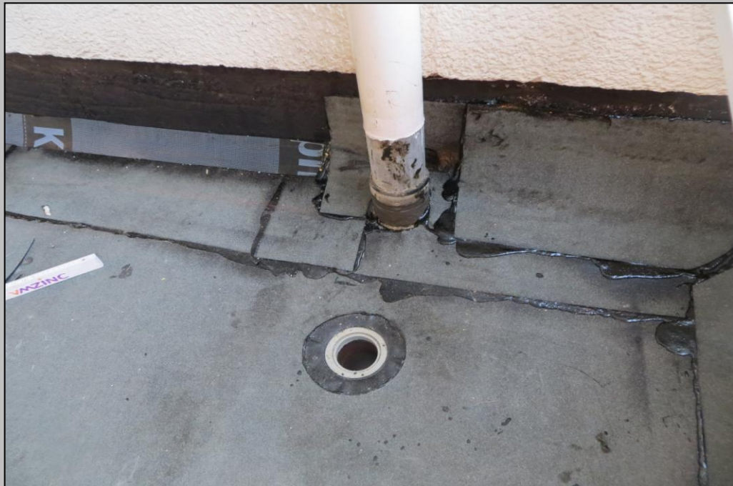
Foto 10 - Abdichtung am Balkoneinlauf
