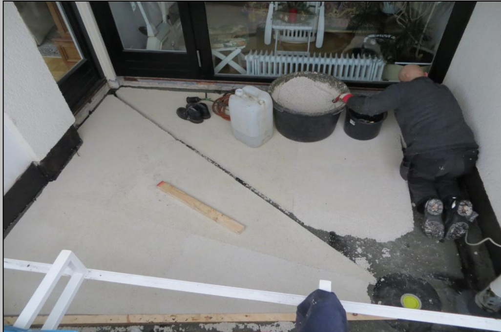
Foto 7 - Einbau der Gefälledämmung
