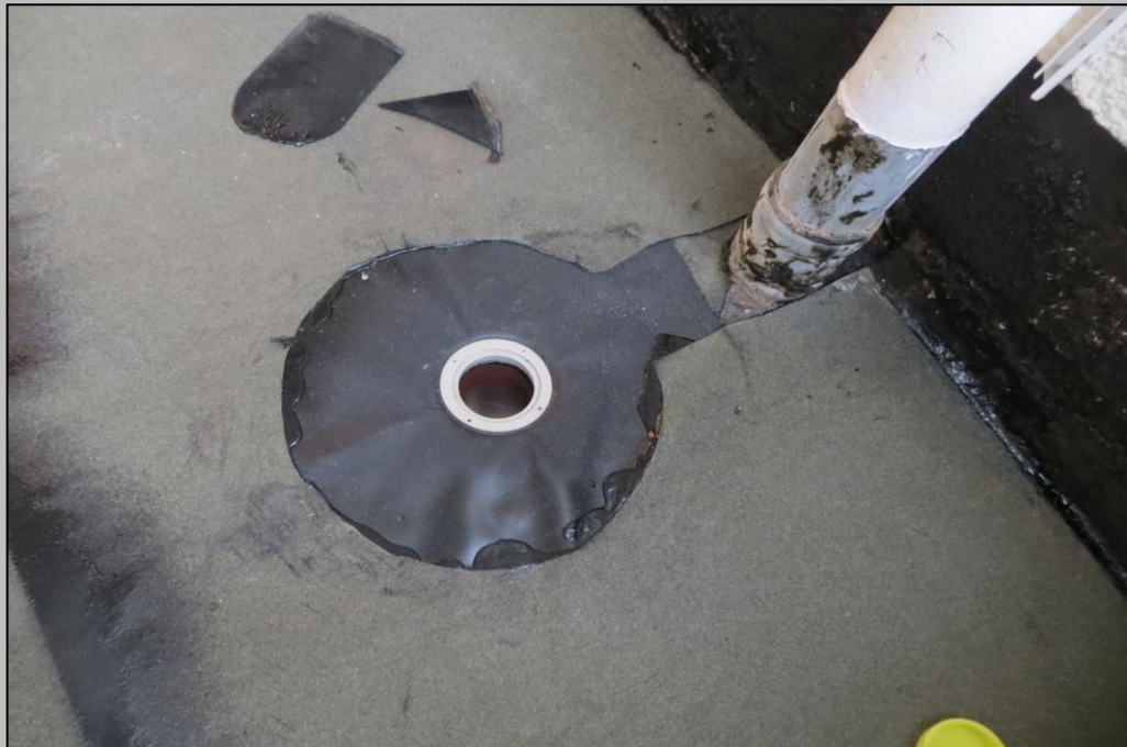
Foto 6 - Einbau der Dampfsperre am Balkoneinlauf
