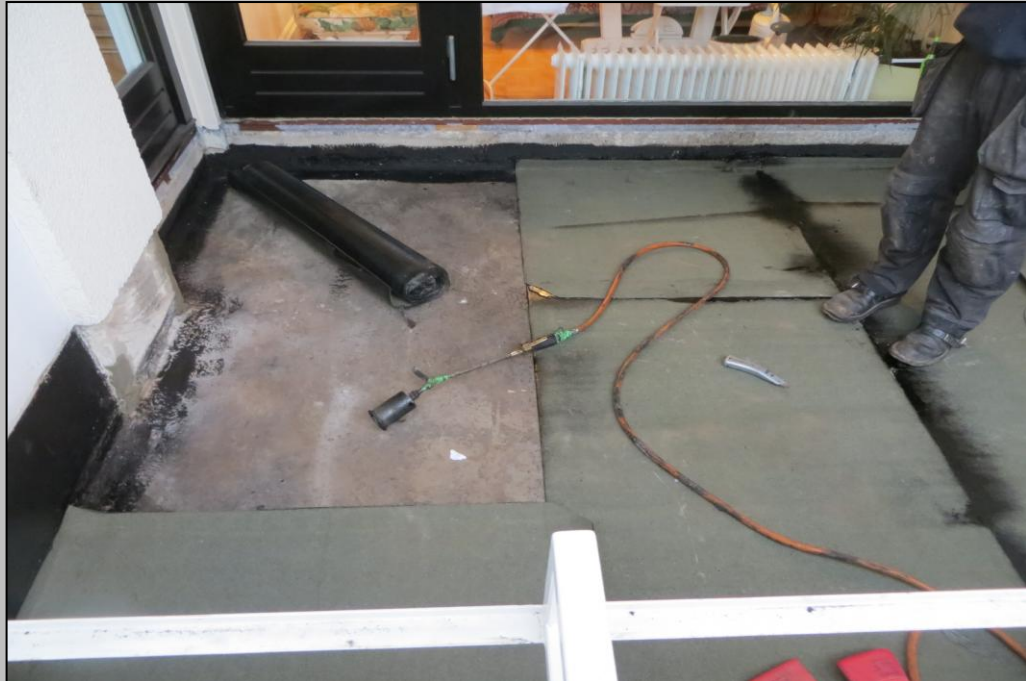
Foto 5 - Einbau der Dampfsperre
