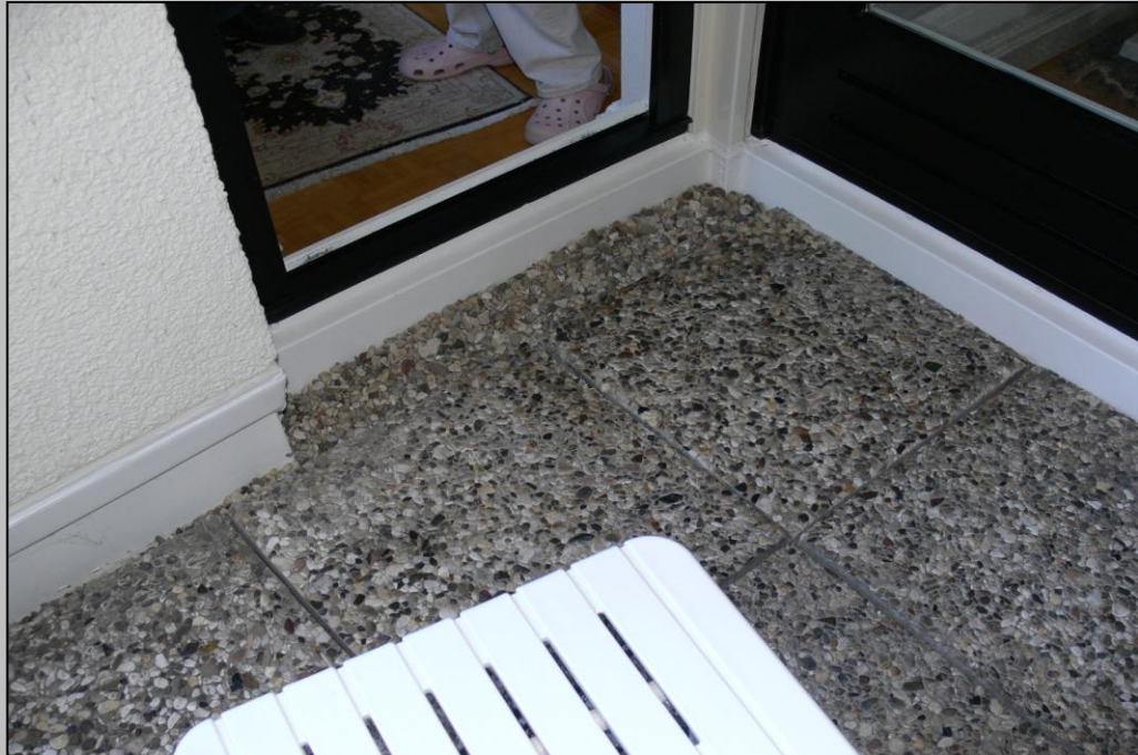
Foto 1 - Bestand, Balkon mit Waschbetonplatten
