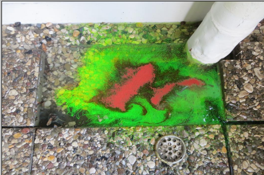
Foto 2 - Flutung des Balkons mit einem Färbemittel
