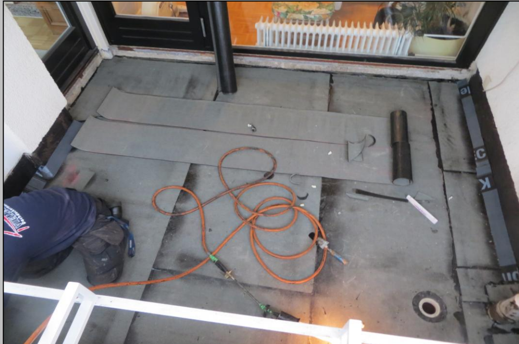
Foto 9 - Einbau der Abdichtungslagen
