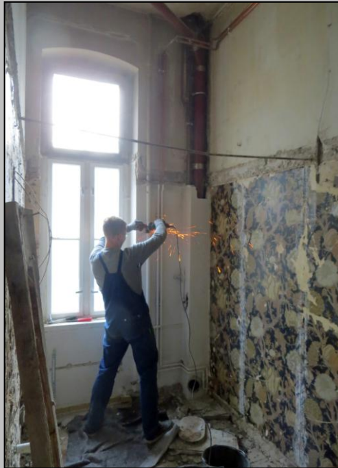
Rückbau Heizungsrohre 13.03.2014
