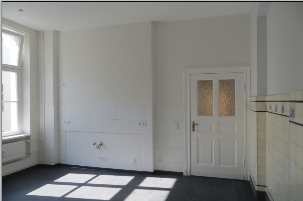
Küche nach der Fertigstellung
