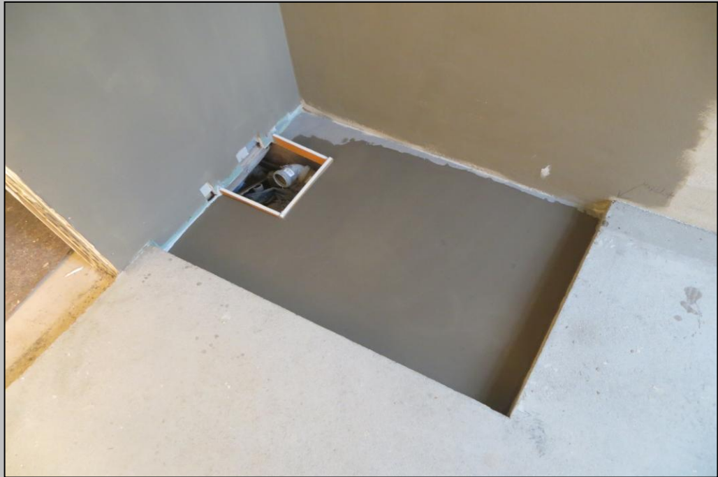
Neuaufbau des Fußbodens
