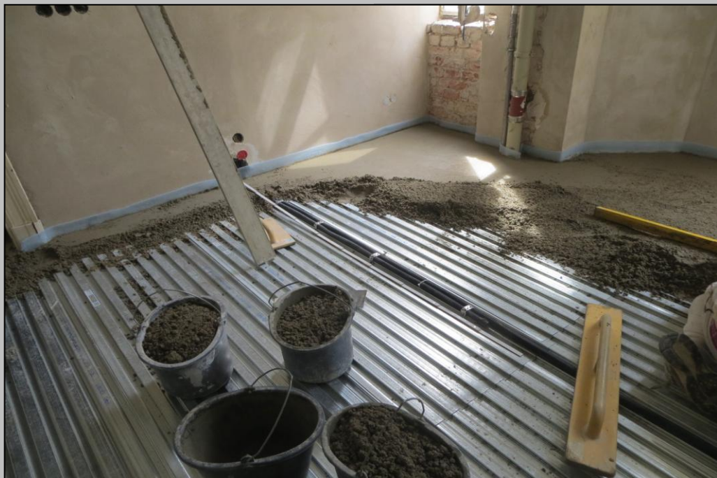
Einbau des Estrichs mit Schwalbenschwanzblechen
